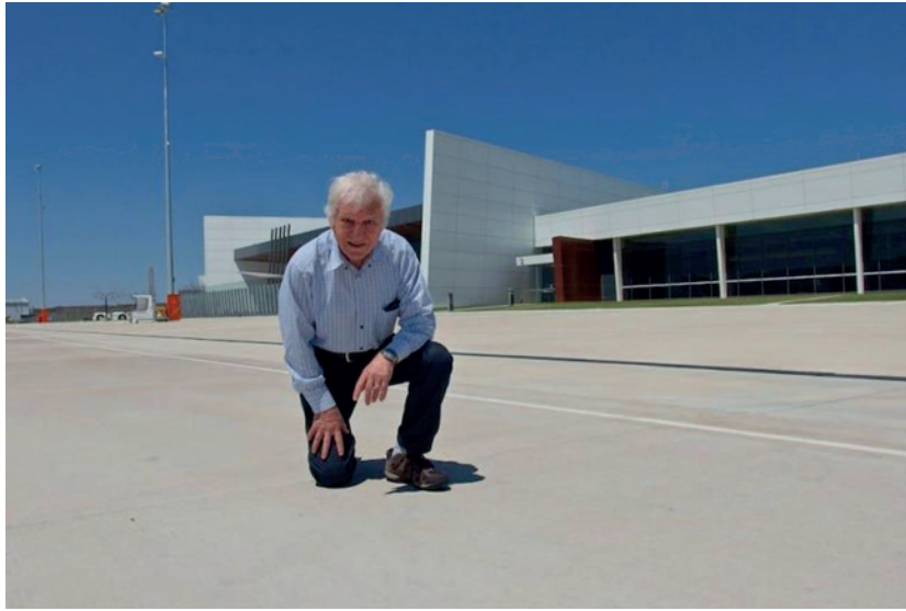
Şekil 9: Wellcamp Havalimanı’nın geopolimer saha kaplaması
