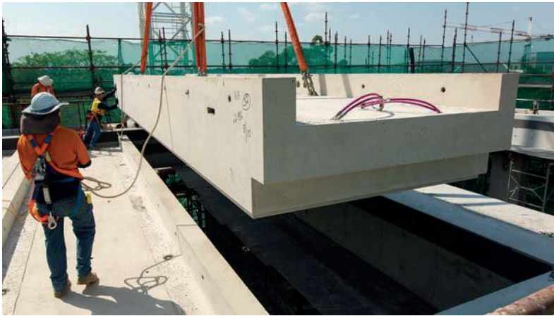
Şekil 8: Queensland's Global Change Institute binasında geopolimer prekast beton döşeme elemanının montajı
